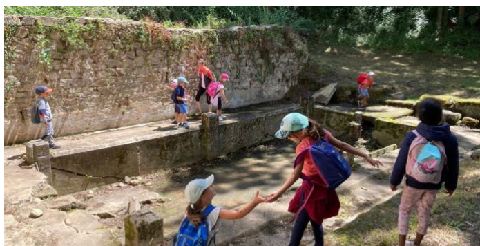
Ce n'est pas une piscine malgré les apparences, mais un lavoir !
